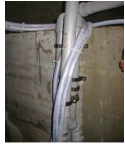
Schläuche an den Hebern nach oben geführt
