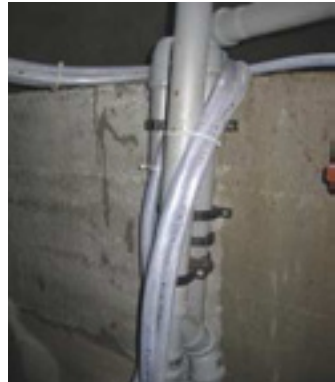
Schläuche an den Hebern nach oben geführt
