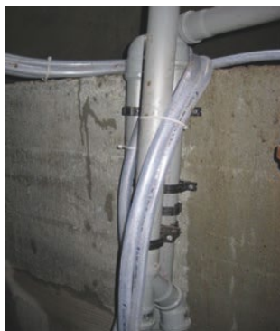
Schläuche an den Hebern nach oben geführt
