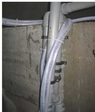
Schläuche an den Hebern nach oben geführt
