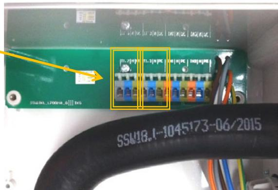
**Abbildung 20:** Anschluss Klarwasserpumpe in Steuerung K-Pilot 18.3
