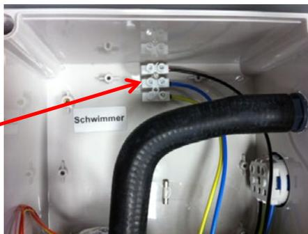
**Abbildung 12:** Anschluss Schwimmerschalter bei Steuerungs-Typ K-Pilot 18.1
