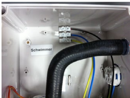
Figur 3: Slangen i styrningens innanmäte får inte vridas.
