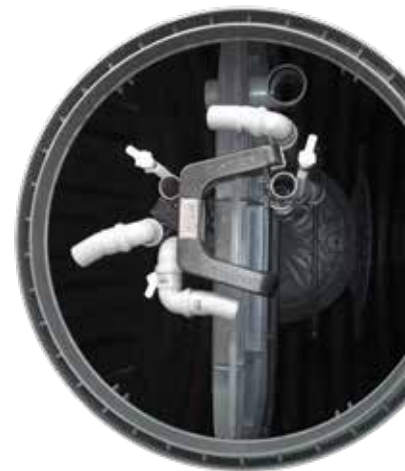
AQUATO® KOM-PAKT Montage in PE-Behälter
