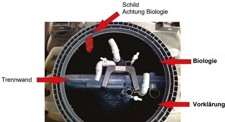
**Abbildung 10: Einhängung Kompaktbügel**
