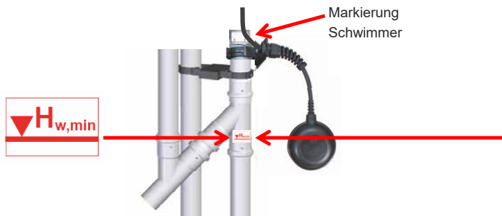
Abbildung 16: Befestigung Schwimmerschalter
