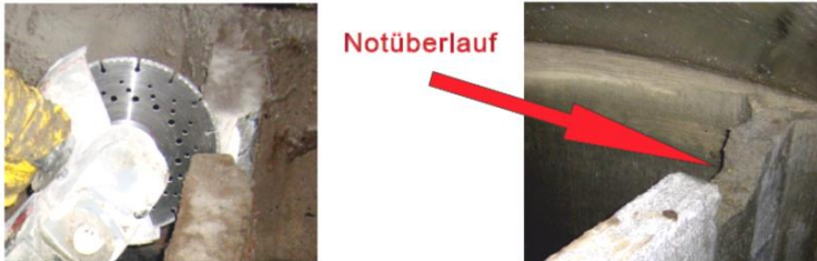
Abbildung 2: Nachrüstung Notüberlauf an Trennwand
