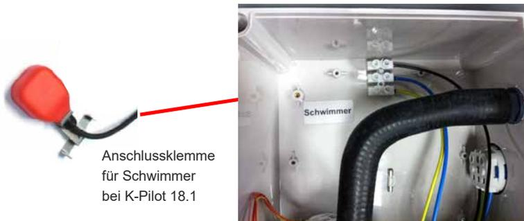
Abbildung 28: Anschluss Schwimmerschalter in K-Pilot 18.1
