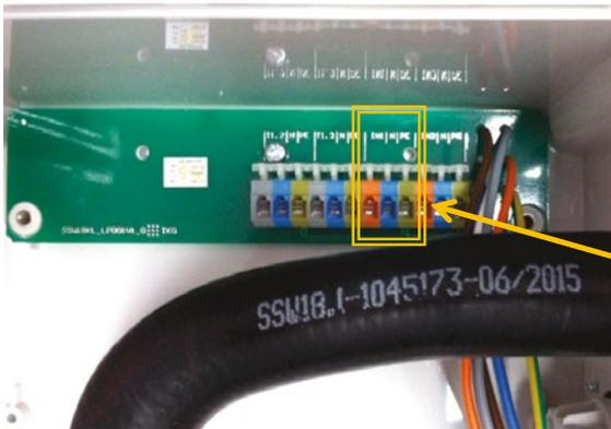
Anschluss für Schwimmerschalter für Steuerungstyp „Schwimmer“ und Hochwassermelder an Klemmen IN 1, N, PE
