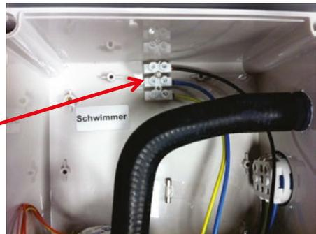
**Abbildung 13:** Anschluss Schwimmerschalter bei Steuerungs-Typ K-Pilot 18.1
