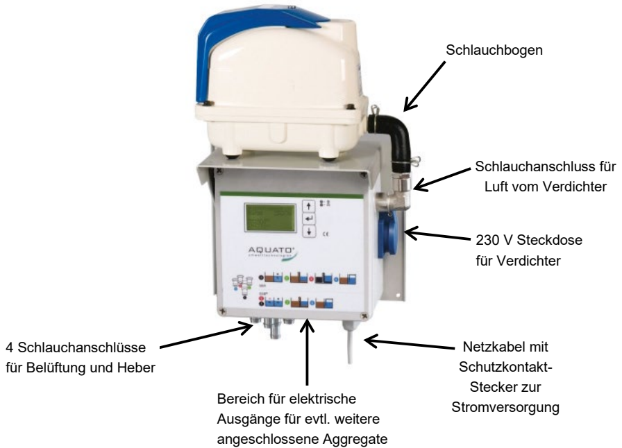
Abbildung 2: Anschlüsse an der Steuerung K-Pilot 18.1/18.3/18.4 mit Verdichter auf Konsole
