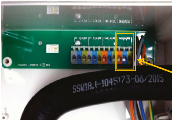
Abbildung 19: Anschluss Schwimmerschalter für Puffer bei Steuerung K-Pilot 18.3
